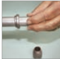
Introduzir a Junta de Vedação no Eletroduto.
