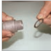
Adicionar a Junta de Vedação para Condutele Múltiplo no conector.
