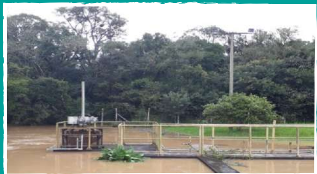
Estação de Tratamento de Água do Minguava após fortes chuvas (01/06/2019)
