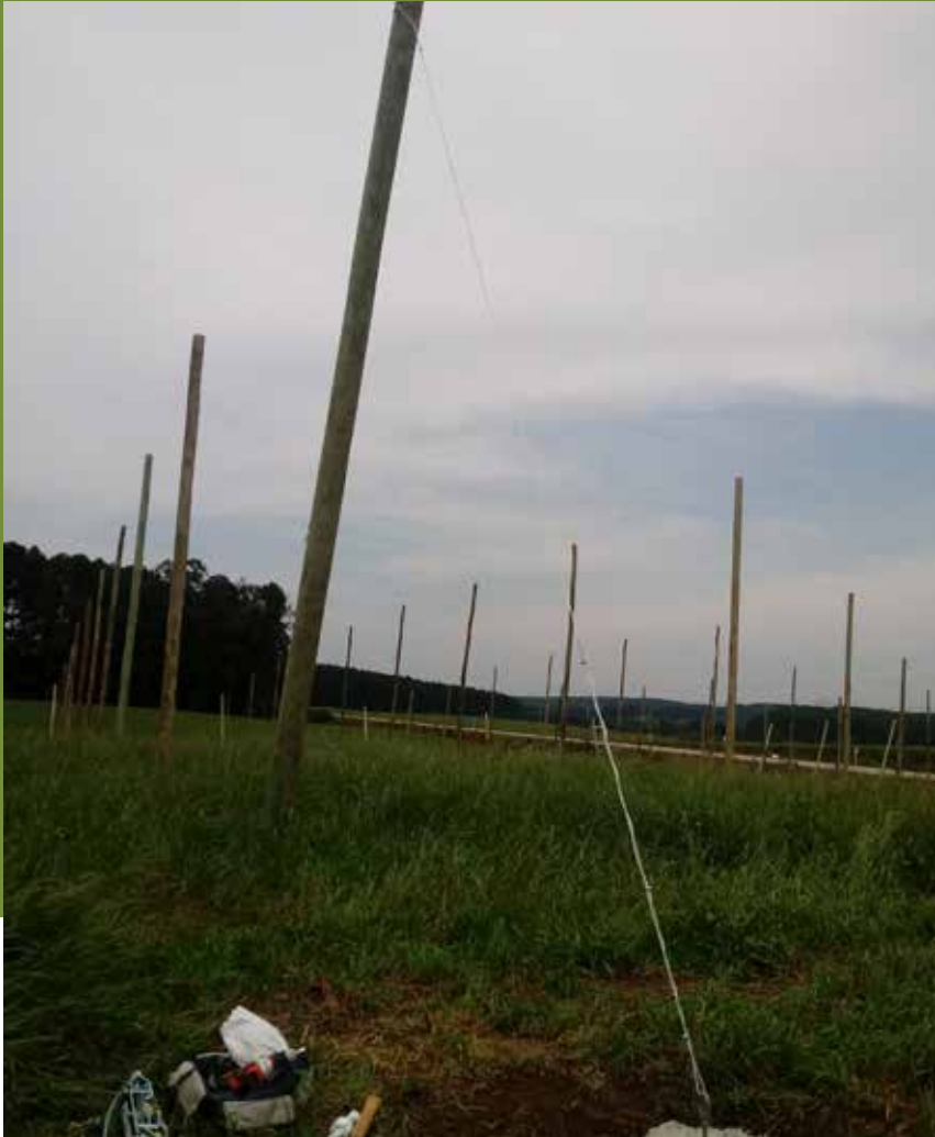
Imagem 18 – Cabo de aço tensionado.
